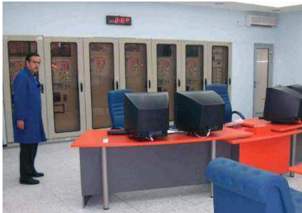
Rys. 7. Nastawnia obsługująca m.in. rozdzielnię 110kV przed i po modernizacji
