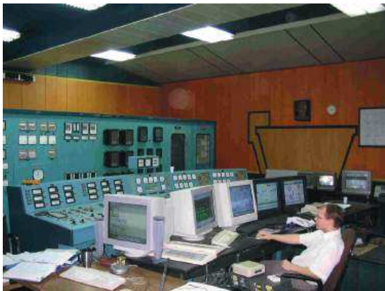
Rys. 7. Nastawnia obsługująca m.in. rozdzielnię 110kV przed i po modernizacji
