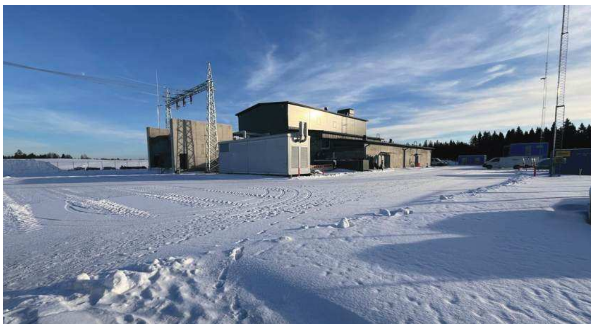
Rys. 4. Widok na obiekty kompensatora synchronicznego
