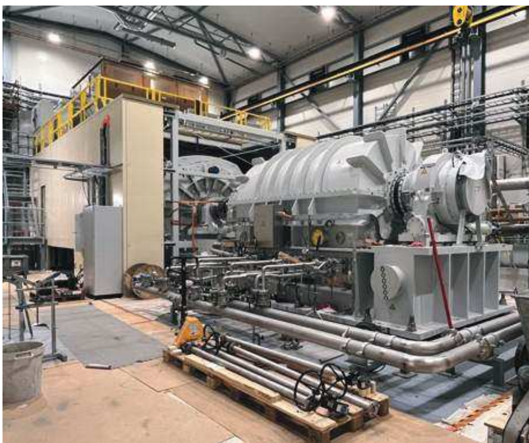
Rys. 1. Kompensator synchroniczny z kołem zamachowym na pierwszym planie
