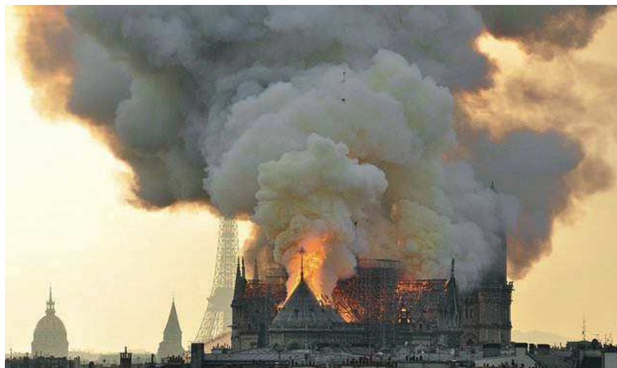
Rys. 7 .Pożar katedry Notre Dam zainicjowany przez instalację elektryczną
