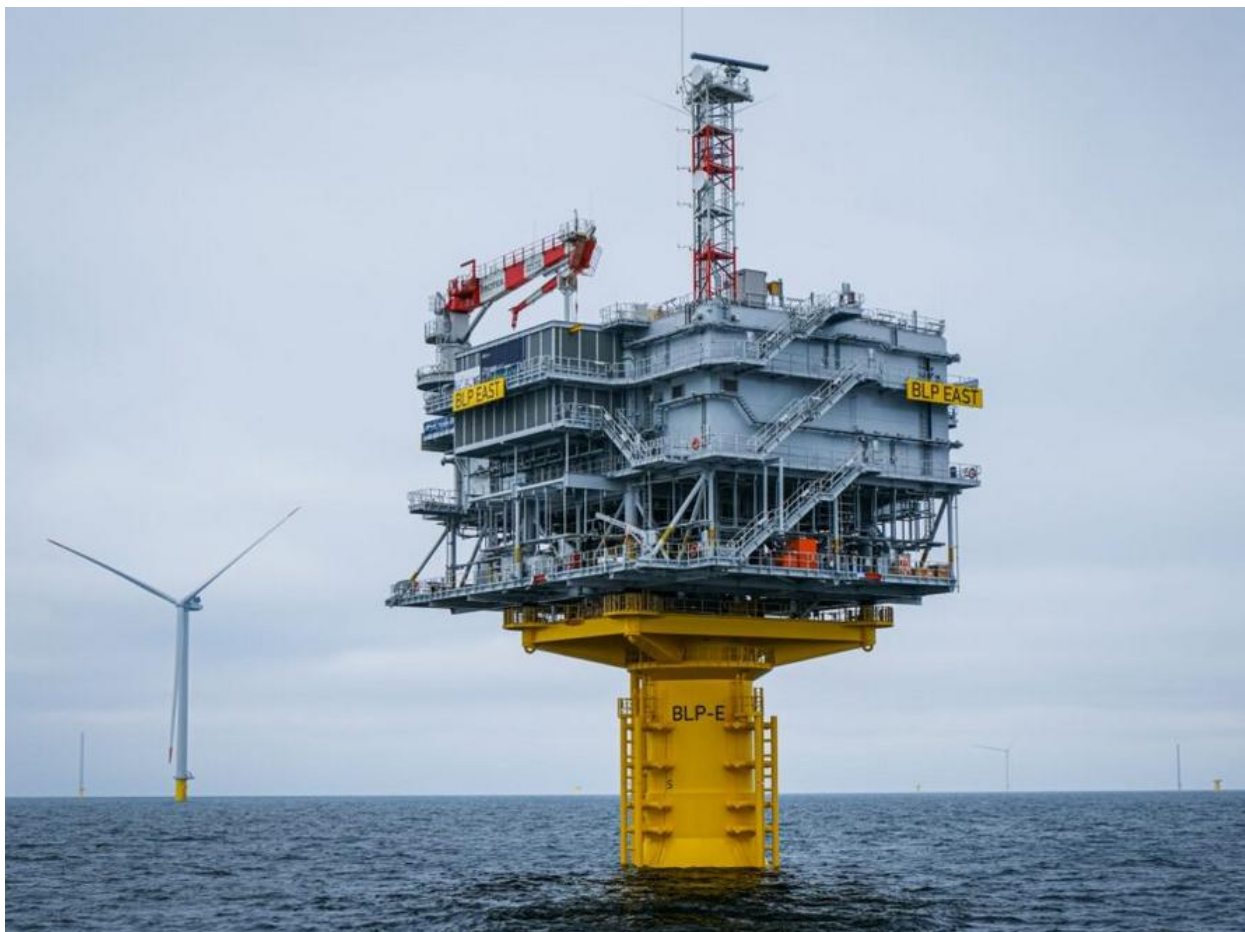
Rys. 5 Stacja morska w technologii HVAC - OSS East spółki Baltic Power [9]
