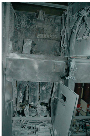
Rys. 4 i 5. Uszkodzone pole - widok na przednią elewację.
