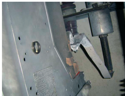
Rys. 8 i 9. Widok uszkodzeń w celce pola - okopcone kolumny wyłącznika i ściany celki, uszkodzone szyny wyłącznika
