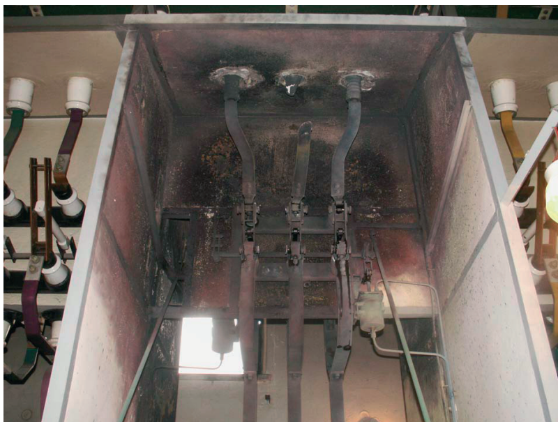
Rys. 6. Miejsce zwarcia: przyłącze szyn
