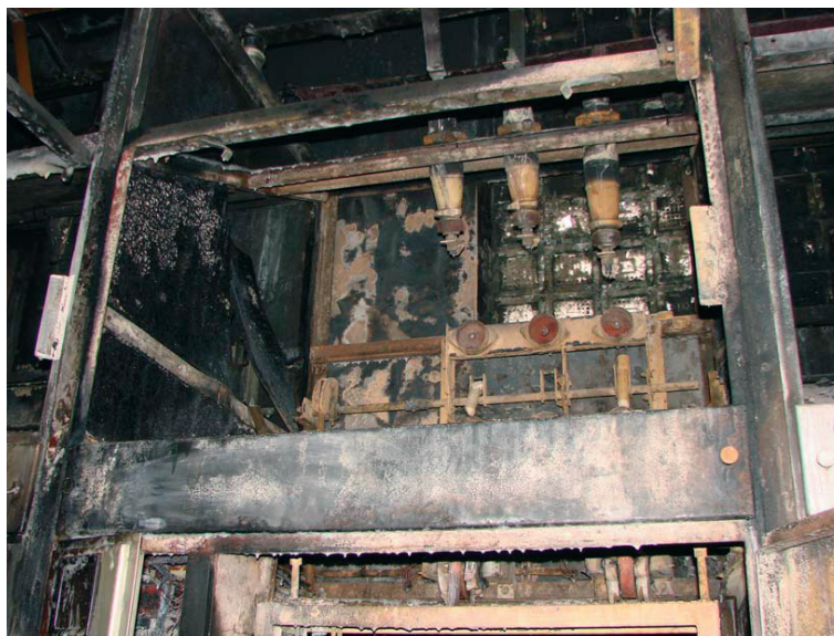
Rys. 2. Odłącznik szyn, w polu w którym doszło do zwarcia.
