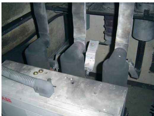
Rys. 8 i 9. Widok uszkodzeń w celce pola - okopcone kolumny wyłącznika i ściany celki, uszkodzone szyny wyłącznika
