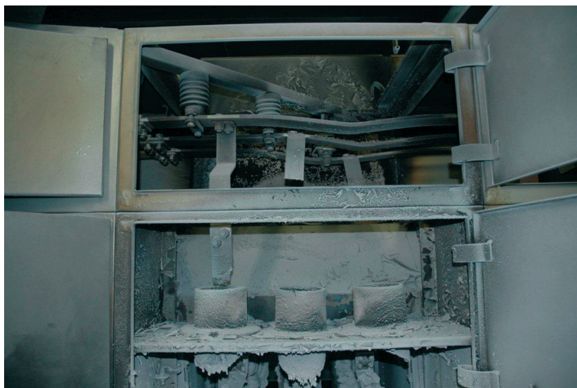
Rys. 3. Miejsce powstania zwarcia. Przyłącze szyn.
